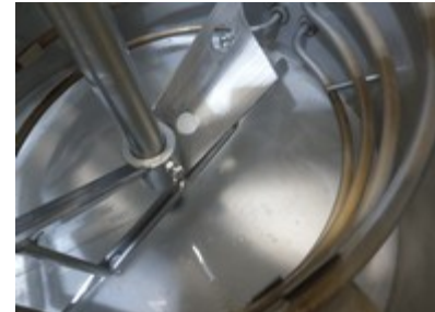
Heizung Sudhaus elektrisch, Gasbrenner oder Dampf
